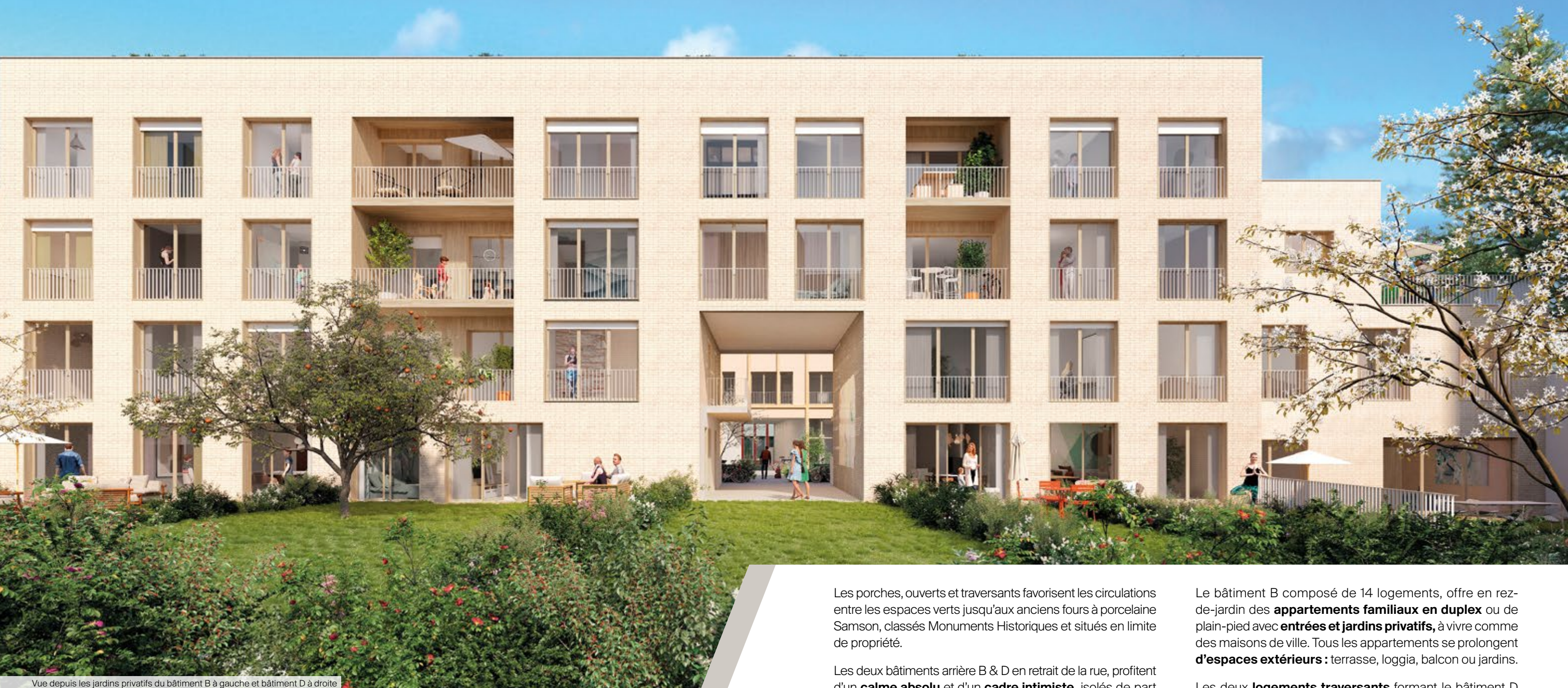
Vue depuis les jardins privés du bâtiment B à gauche et bâtiment D à droite
