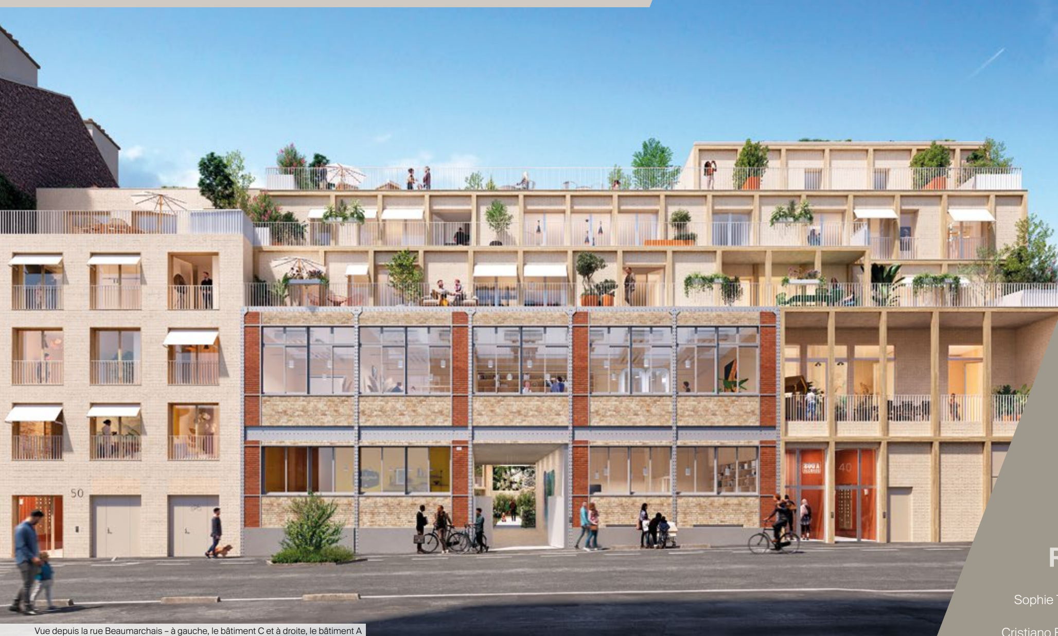
Vue depuis la rue Beaumarchais – à gauche, le bâtiment C et à droite, le bâtiment A
